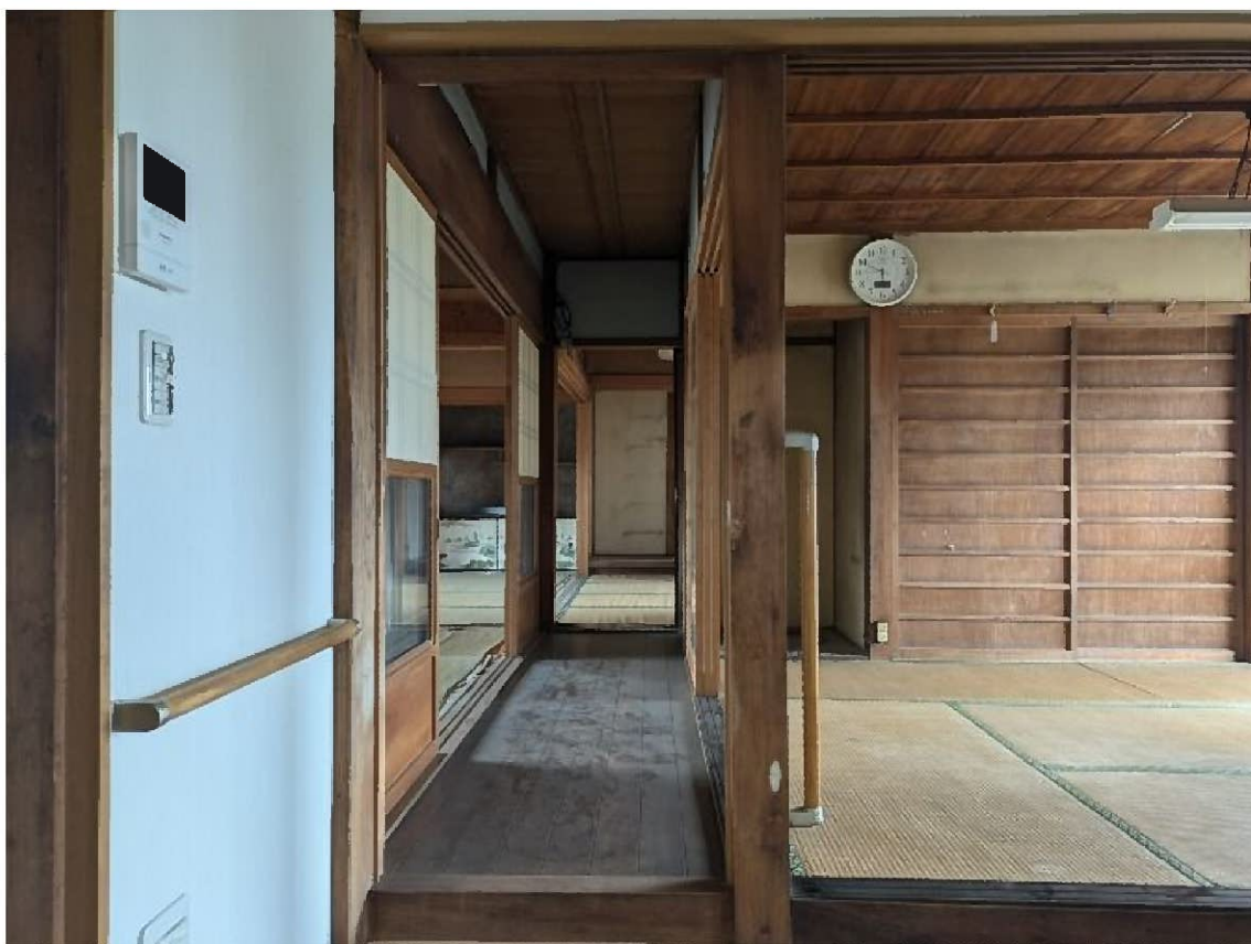
1 階和室② 南側廊下
