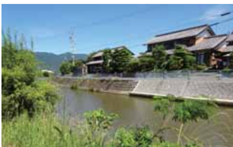
瑞穂大代地内災害復旧工事
