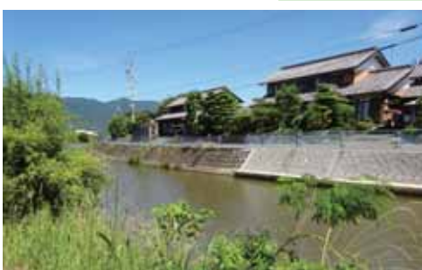
瑞穂大代地内災害復旧工事
