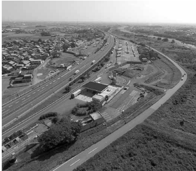
養老SAスマートIC現場
