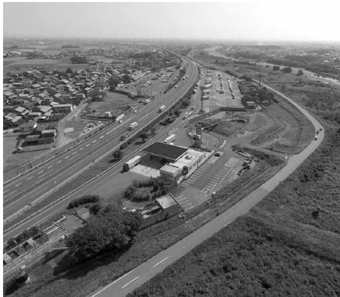
養老SAスマートIC現場
