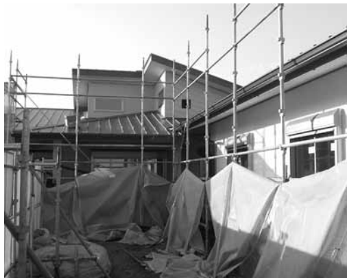
建設中のグループホーム
