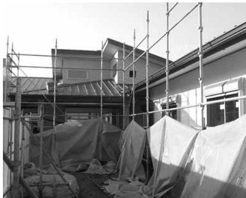
建設中のグループホーム
