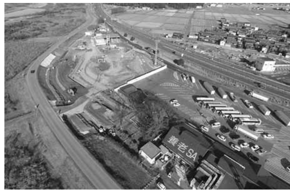
建設が進む養老スマートIC
