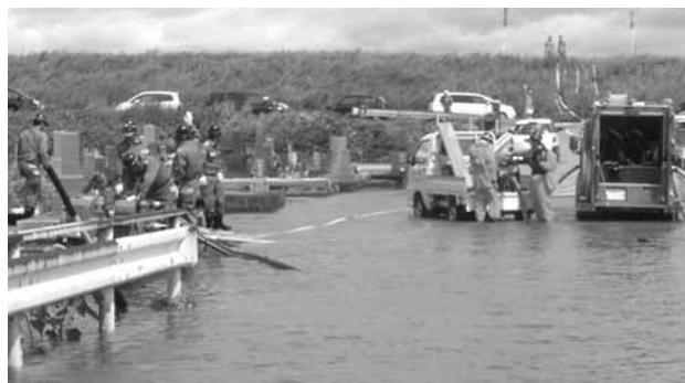
平成25年の浸水被害
