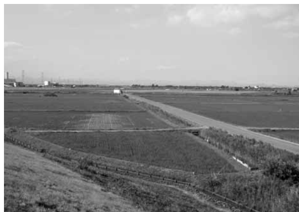
大区画整備（有尾地内）
