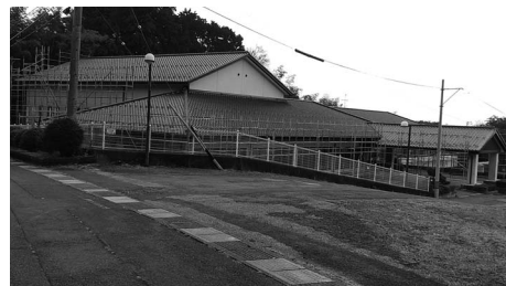
改修中の地域福祉センター
