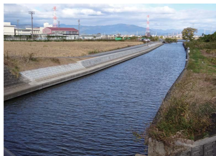
五三川の改修された護岸
