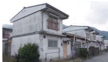
今後売却が検討される改良住宅
