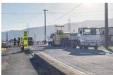
町内道路工事現場
