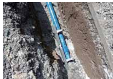
耐震管布設替工事写真
