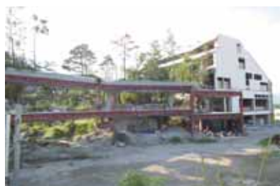
出資企業の建設現場
