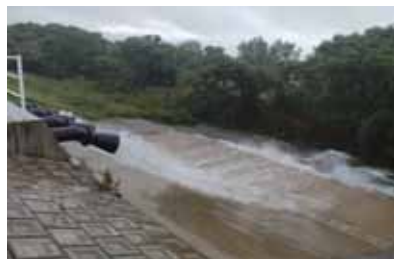
台風10号時 排水機稼働
