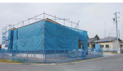
建設中の病児病後児保育施設
