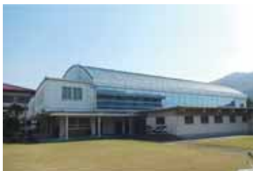
高田中学校屋内運動場
