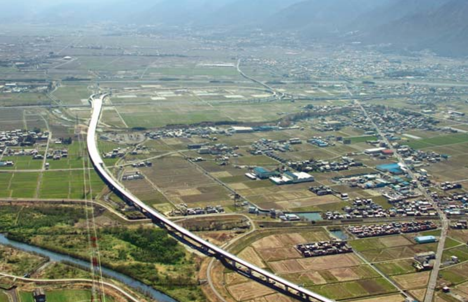
養老インターチェンジ（仮称）の開業が決定している東海環状自動車道は2020年の全線開通をめざして工事を進めています。
